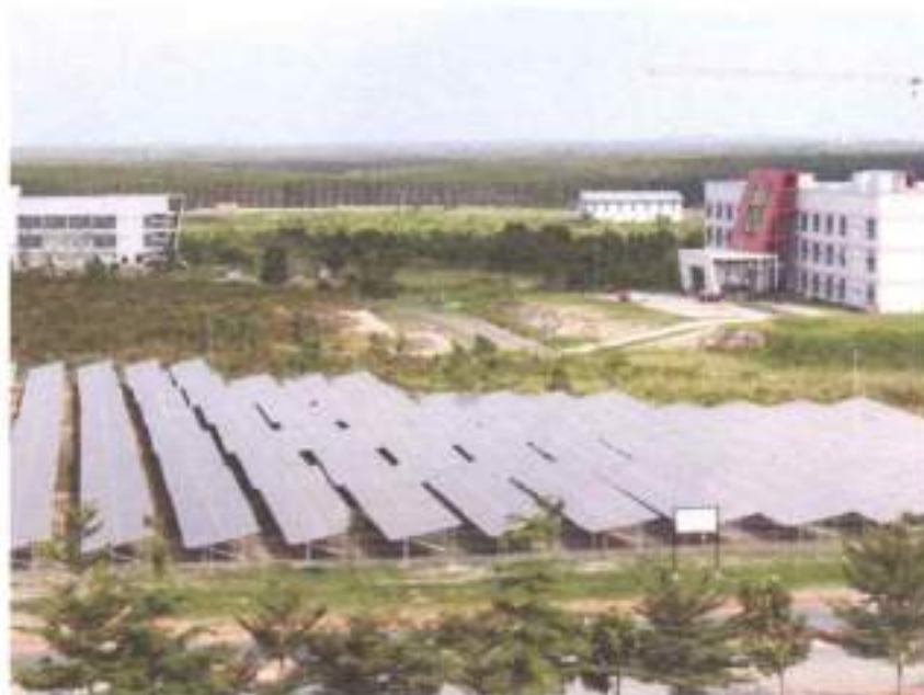
Gambar 2.9 Pembangkit Listrik Tenaga Surya
